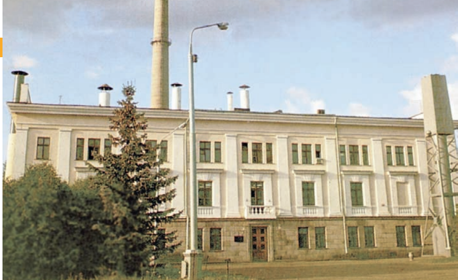
В этом здании расположена Первая в мире АЭС
