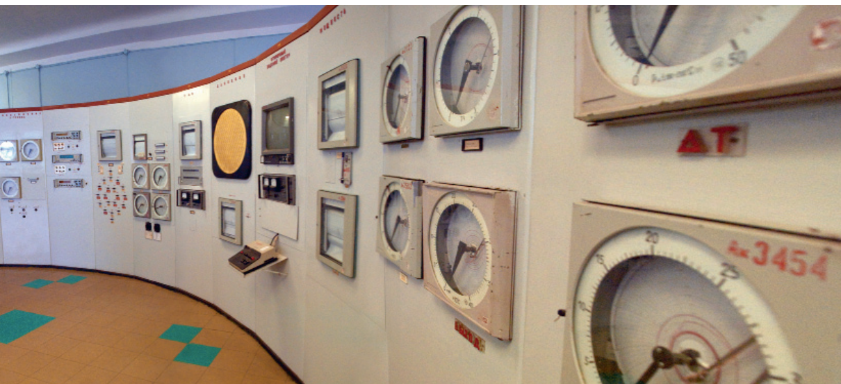
Зал управления Первой АЭС
