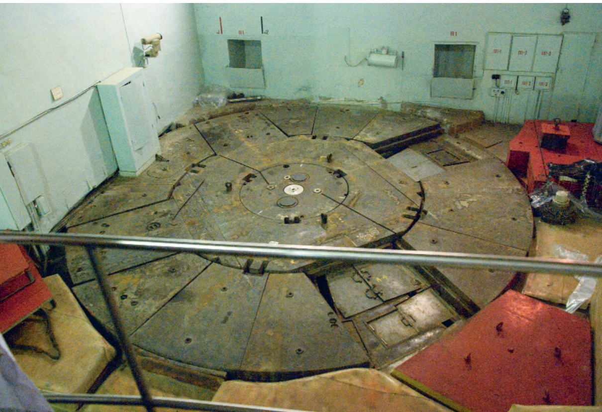
Крышка реактора первой АЭС
